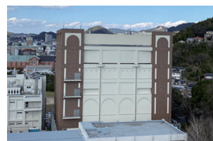
高度安全実験施設 (BSL-4 施設) 外観 長崎大学高度感染症研究センター https://www.ccpid.nagasaki-u.ac.jp/
